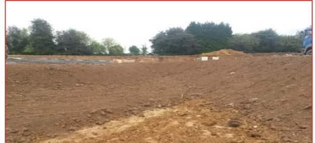
Recapage de la terre végétale
