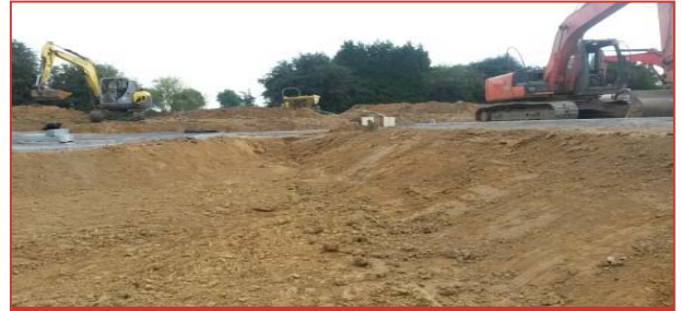
Réalisation des terrassements
