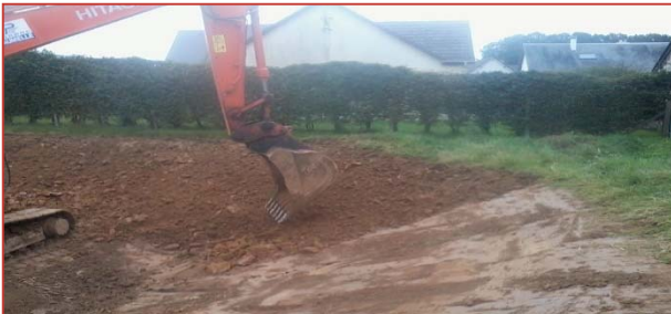
Décompactage et griffage
