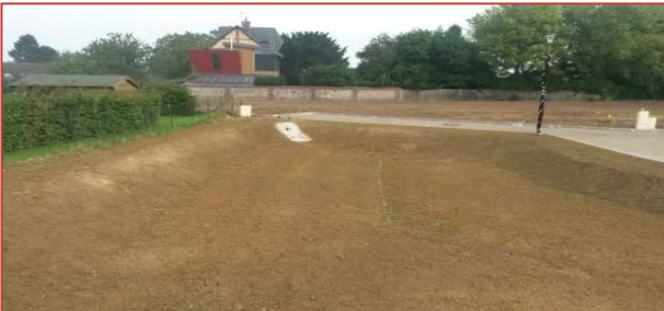
Finition des terrassements
