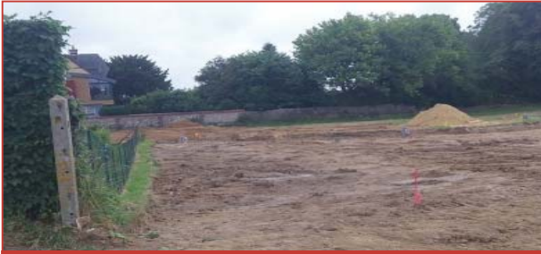
Décapage de la terre végétale
