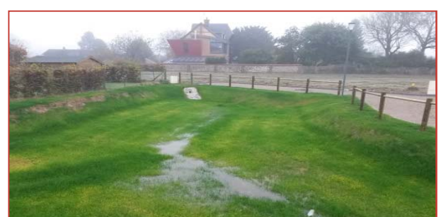
Première mise en eau de l'ouvrage
